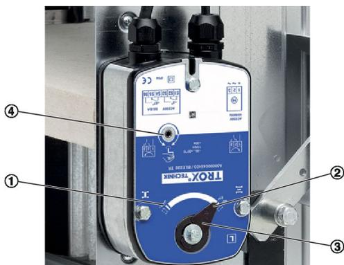
Abb. 21: AUF-ZU-Stellantrieb (Entrauchungsklappe geöffnet)
