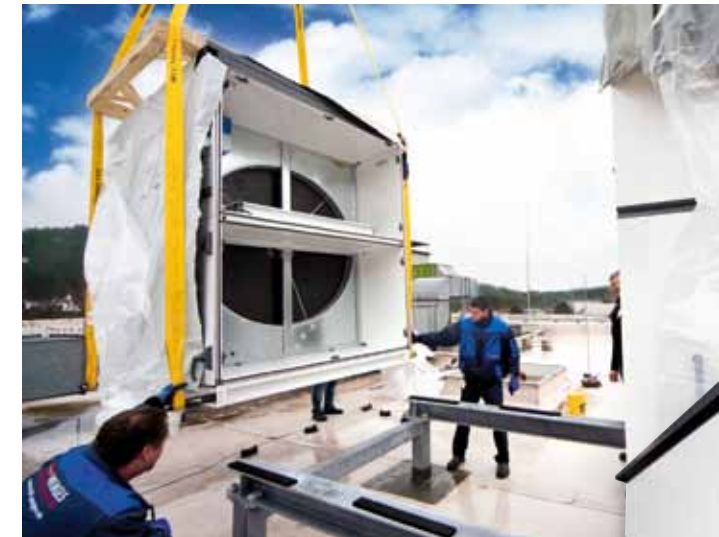
Dachinstallation auf die vorbereitete Stahlkonstruktion
