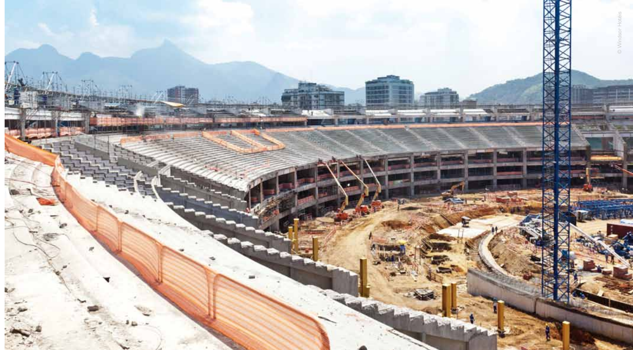
... wird für die WM innerhalb der denkmalgeschützten Fassade neu aufgestellt.
