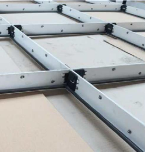
Die Filterwand Serie SIF und die Standard-Zellenrahmen Serie SCF von TROX wurden für den Einbau von Filterelementen zur Abscheidung von Grob- und Feinstaub sowie gasförmigen Geruchs- und Schadstoffen entwickelt. Sie sind wartungsfrei, da aufgrund der Konstruktion und der verwendeten Materialien keine Abnutzung erfolgt. Bei Verwendung in RLT-Anlagen können Taschenfilter, Mini Pleat Filtereinsätze, Aktivkohle-Filtereinsätze, Mini Pleat Filterplatten oder Z-Line Filter verwendet werden.
